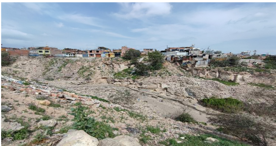
FIGURA N°02: SE OBSERVA TRAMO CRÍTICO COLMATADO CON RESIDUOS SOLIDOS Y DESMONTE EN LAS MARGENES DE LA QUEBRADA ESTANQUILLO
