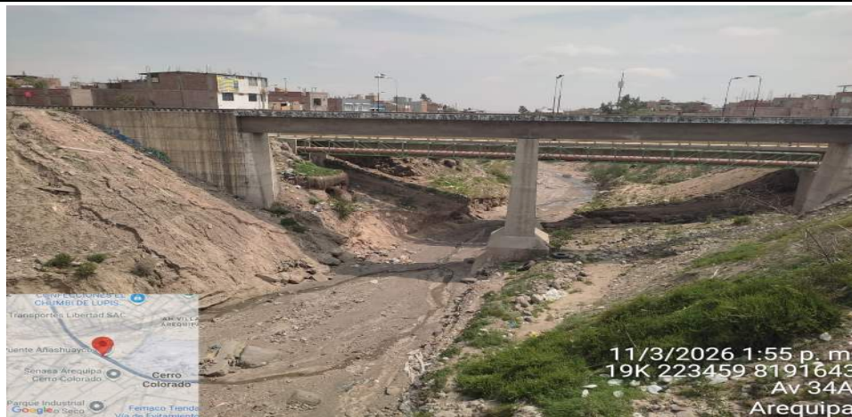
FIGURA N°01: TRAMO CRÍTICO EN LA QUEBRADA ESTANQUILLO A LA ALTURA DEL PUENTE AÑASHUAYCO COLMATADO Y EROSION EN LOS TALUDES.
